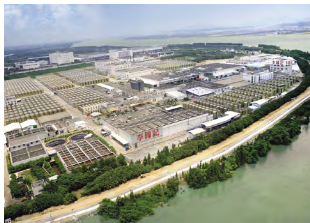
▲ 新會廠房於今年6月正式啟用太陽能光伏發電系統。
